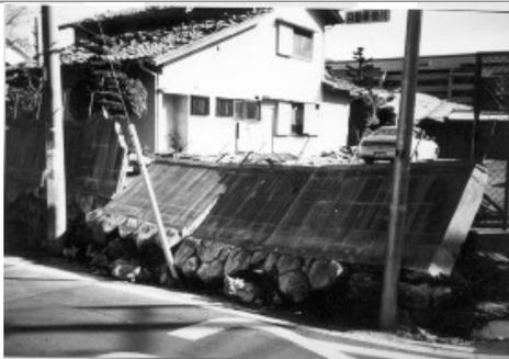
石垣の上につくったブロック塀で、石垣自体の強度も不足で転倒した地震被害の例
