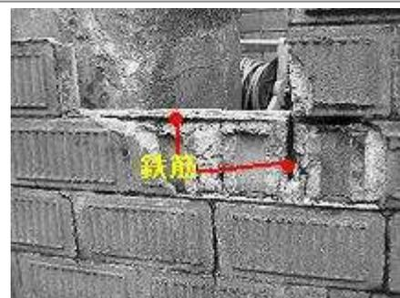
ブロックの中の鉄筋が錆びて、ひび割れができ、ブロック表側が剥がれ落ちた例
