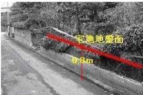
高さ1mの土留め壁の地震被害の例
