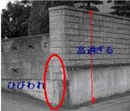
新旧の塀の取り合い部分の基礎と塀に、大きなひび割れが発生していて非常に危険な例(高さ3.1mの塀)
