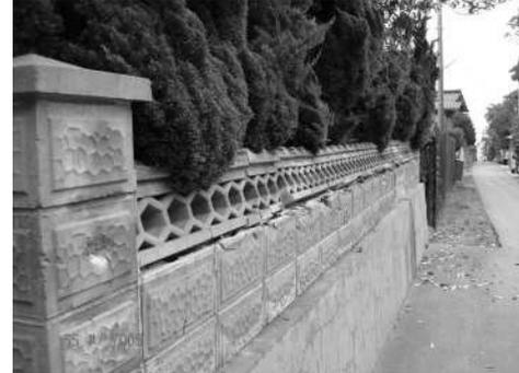
最上段に透かしブロックを連続使用した地震被害の例(縦筋が透かしブロックの部分に入らない結果)
