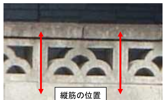
写真5 透かしブロック
