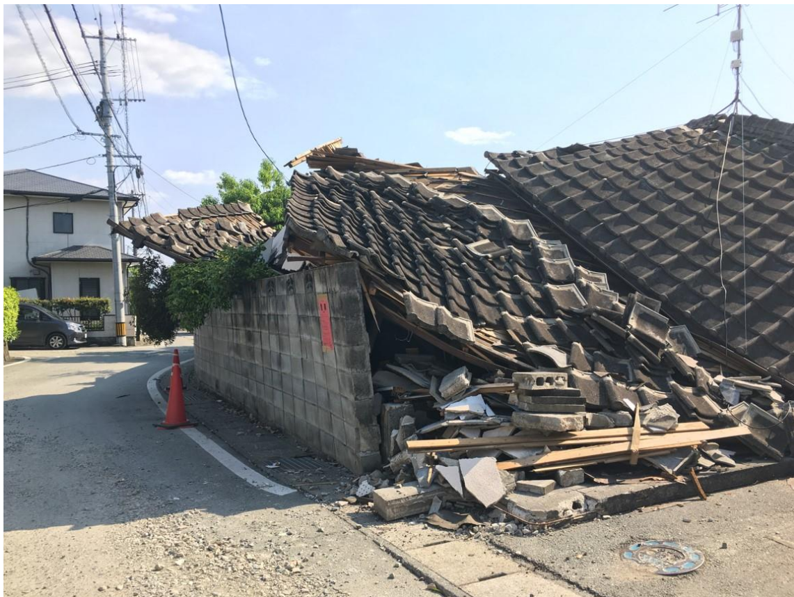
写真 1 倒壊した住宅を支えるブロック塀
